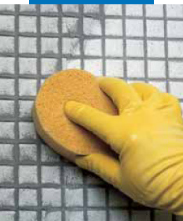
Очистка стеклянной мозаики губкой
