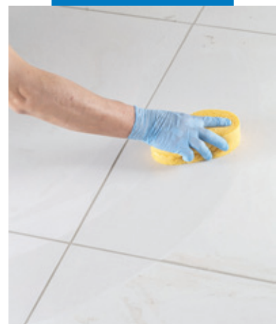
Окончательная очистка плитки с помощью целлюлозной губки
