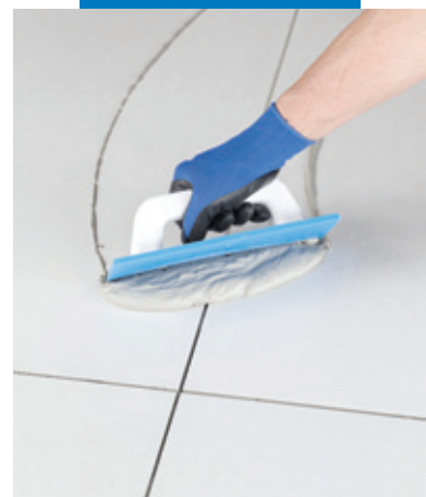
Нанесение Ultracolor Plus на пол из керамогранита резиновым шпателем
