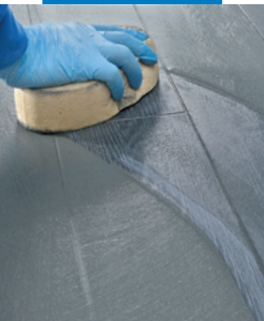
Окончательная очистка плитки с помощью целлюлозной губки
